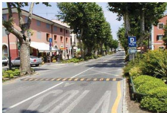
*Fig. 3. Speed humps (Izola)*
