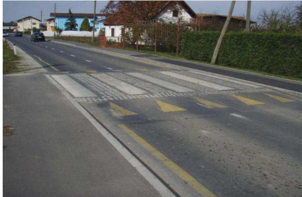
Fig. 4. Speed platform (Rače)
